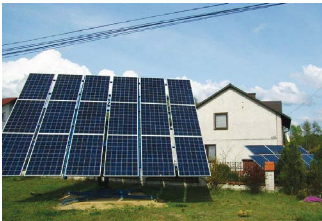
Fot.3. Nadążna fotowoltaika na trakerach, woj. podkarpackie
