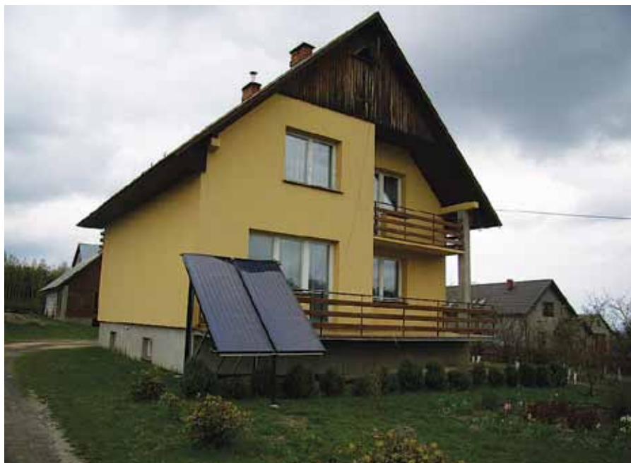
Fot. 1. Płaskie kolektory słoneczne w gospodarstwie woj. lubelskie
