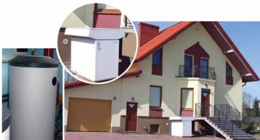
Fot.5. Powietrzna pompa ciepła w gospodarstwie rolnym woj. mazowieckie
