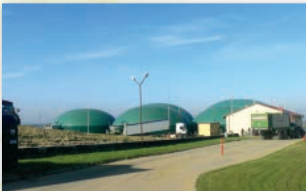
Fot.6. Biogazownia w Grzmiącej woj. zachodniopomorskie. Docelowa moc instalacji 1,6 MW. Ciepło wyprodukowane w biogazowni jest wykorzystane do ogrzania obiektów użyteczności publicznej – szkoły, hali sportowej, ośrodka zdrowia oraz osiedli mieszkaniowych
